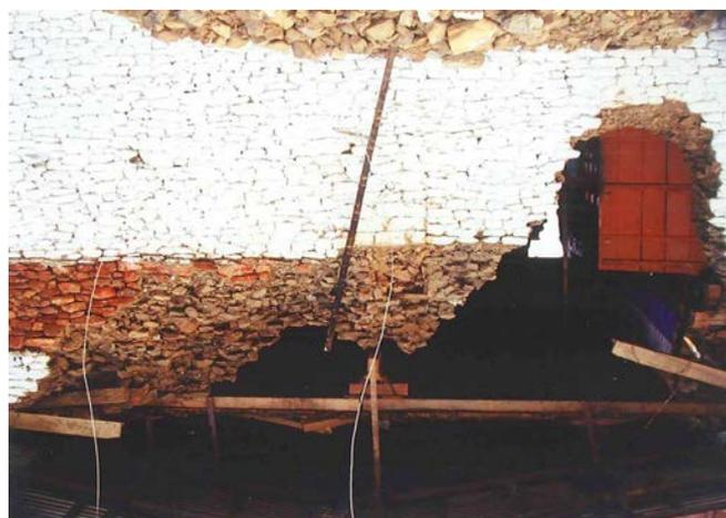
*Abb. 2 Die eingestürzte Rückwand des Tempels von Yangner.*
