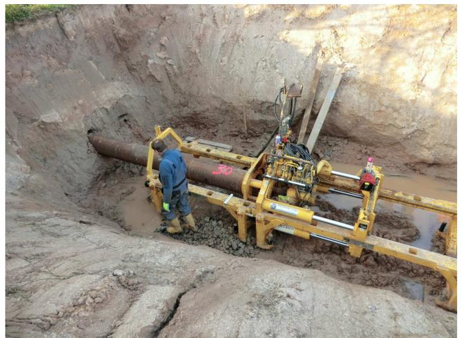
*Bild 3: Bauarbeiten Nahwärmenetz, Durchpressung u. a. der Kreisstraße K3 im April 2012, Länge 55 m*
