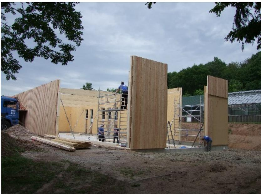
Aufbau einer 300 m<sup>2</sup> großen Ausstellungshalle 2011, DEULA Witzenhausen, Bauweise: Holztafelbau mit Zelluloseausblasung, außen zusätzlich Holzfaserdämmplatten und hessische Lärchenholzverkleidung (unbehandelt)
